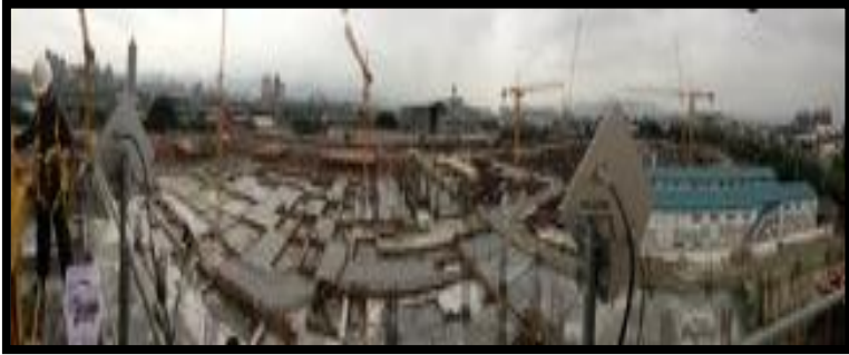
從工務所錄影監控中心 遠端擷取現場畫面
