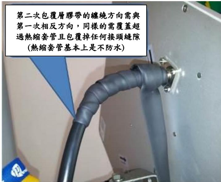
第二次包覆層熱融膠帶的覆蓋面積需蓋過第一次的包覆面積，膠帶的覆蓋面積重疊需超過 1/3 面積，盡可能包覆掉任何接頭的可能縫隙
