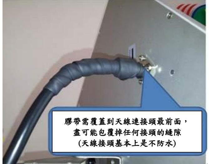
膠帶需覆蓋到天線連接頭最前面，盡可能包覆掉任何接頭的縫隙
